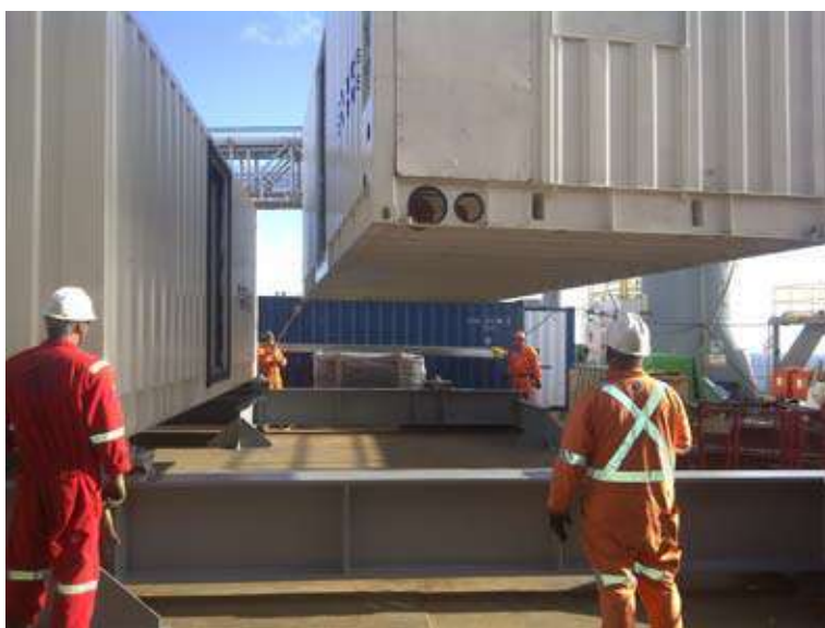
УСТАНОВКА МОДУЛЕЙ НА ПАЛУБЕ
